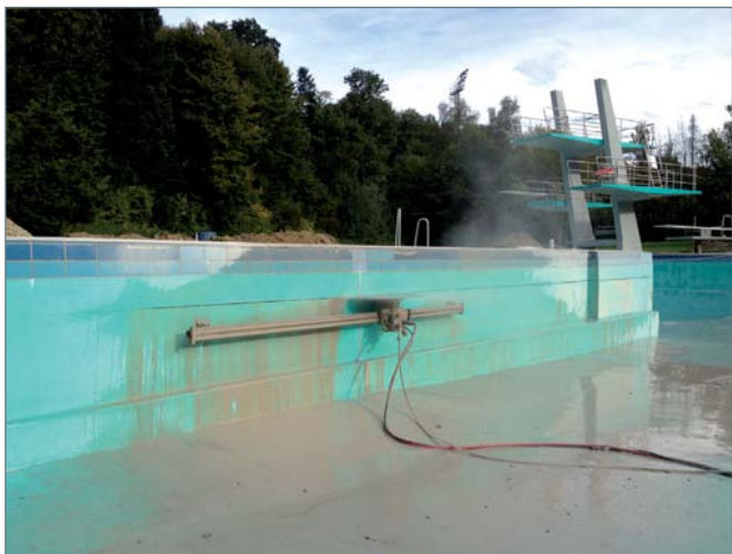
■ Trennschnitt des alten Beckenkopfes; Fotos (ohne weitere Quellenangabe): Antec, Koblenz
