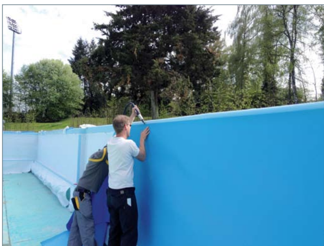
■ Befestigung der Folie an die Beckenwand
