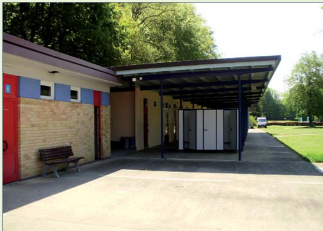
■ Überdachter Bereich vor den Umkleiden
