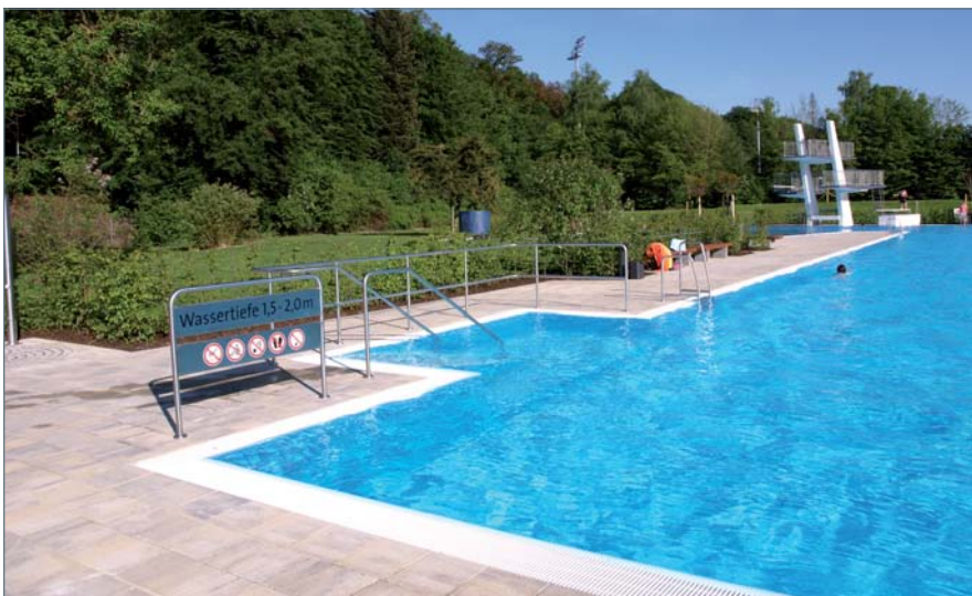
■ ... sowie die neue Einstiegstreppe
