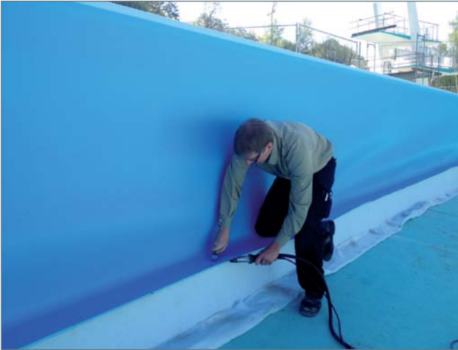
■ Ausarbeiten der Stehstufe
