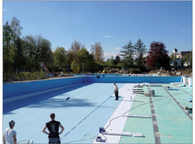
■ Verlegen der Folienauskleidung
