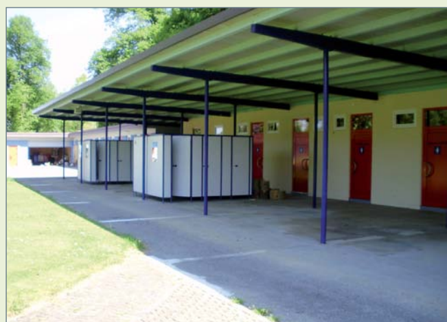
■ Zugang von der Badeplatte zum Umkleidebereich
