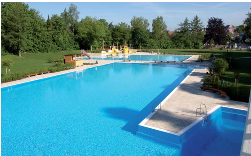
■ Die Sanierung der Badebecken ...
