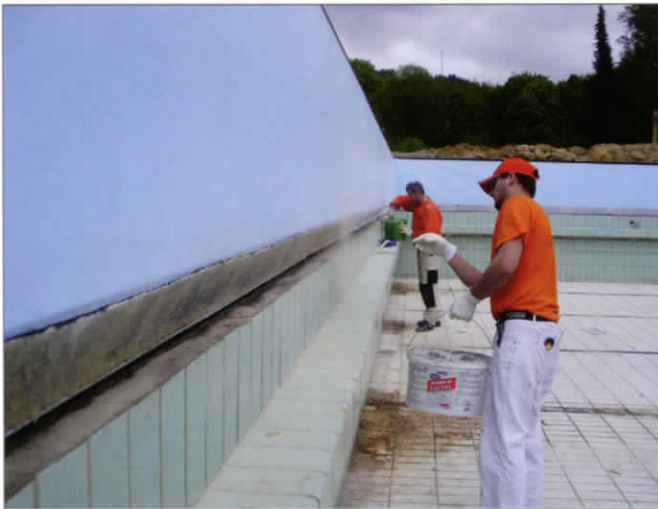
■ Vorbereitende Arbeiten zur Verfüllung und Abdichtung der Verwahrnut
