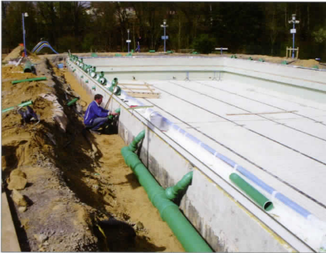
■ Sammelleitung für das Reinwasser und Anschlüsse an die neue Rinne
