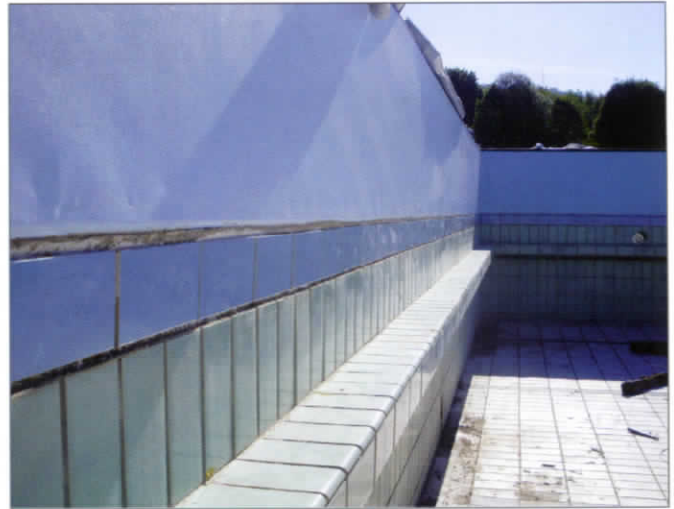
■ Abgedichtete Verwahrnut mit verlegter Fliese
