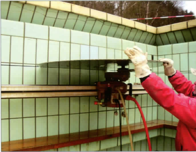
■ Die Überlaufrinne des Bestands
