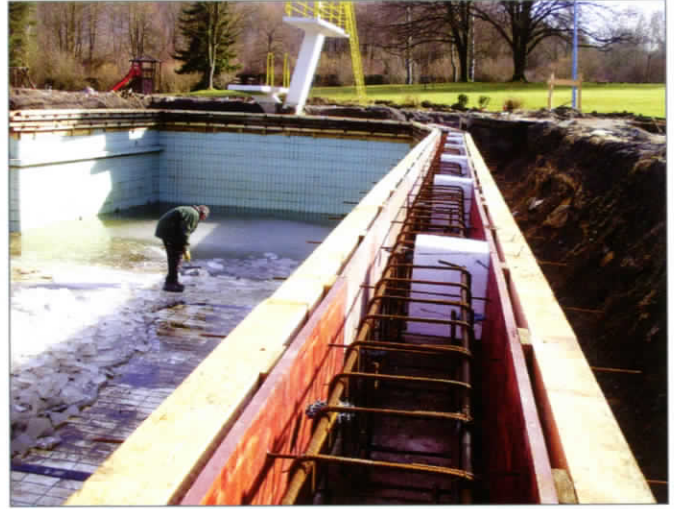
■ Die Herstellung des Ringankers
